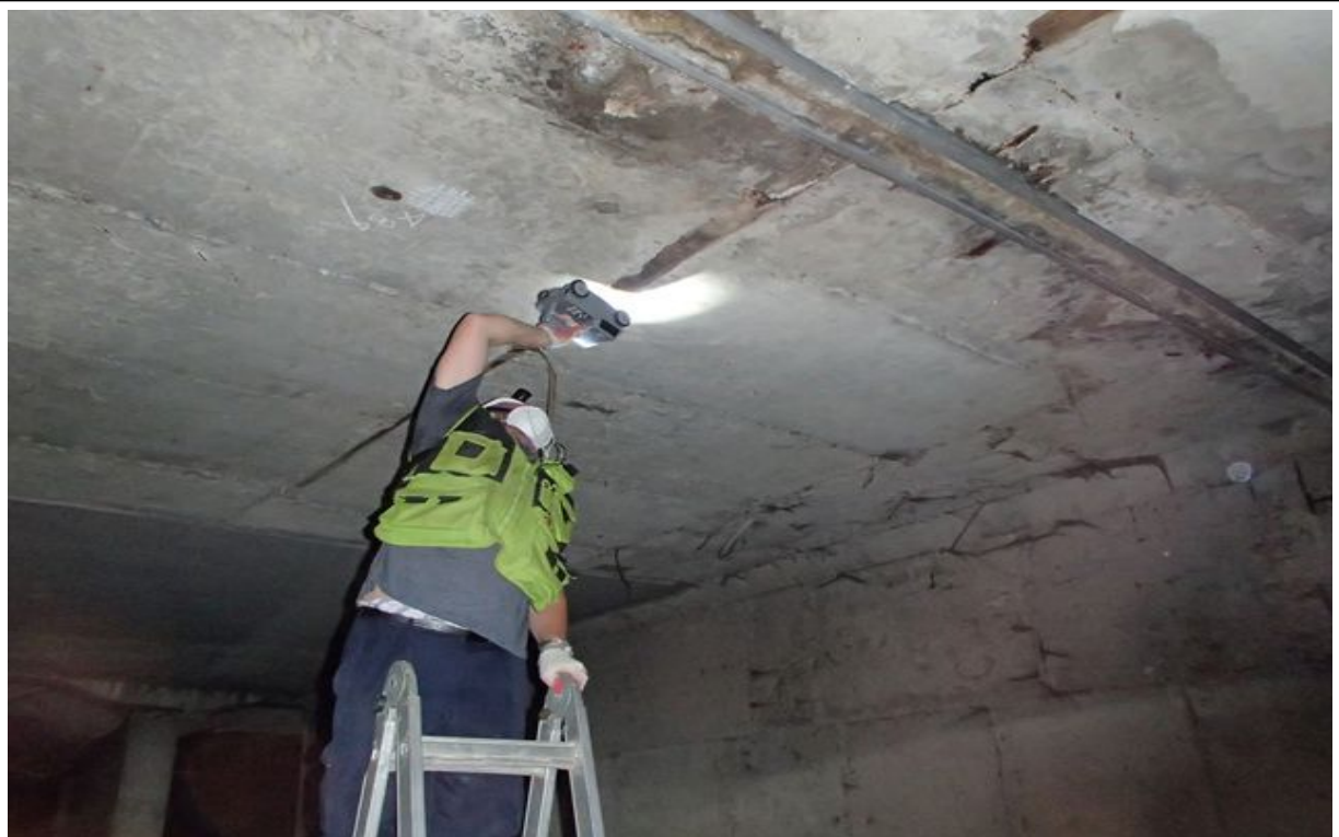
비파괴 검사(철근탐사를 이용한 피복두께 측정)
