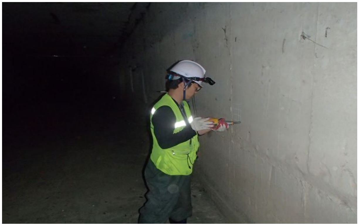
비파괴 검사(슈미트를 이용한 강도검사)
