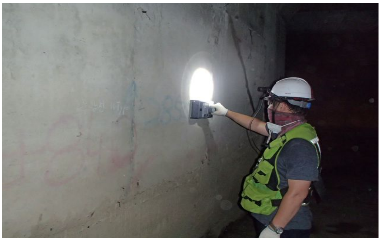
비파괴 검사(철근탐사를 이용한 피복두께 측정)
